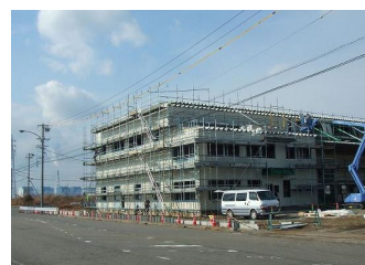
建設中の新工場(約10,000㎡) 黒龍産業(株)西尾工場
